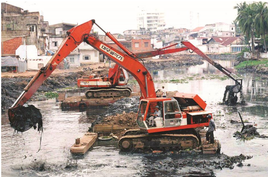
Nạn vét kênh Nhiêu Lộc - Thị Nghè đoạn phường 14, quận 3 thuận lợi nhờ các hộ trên lòng kênh đã di dời. Ảnh: Nguyễn Công Thành
